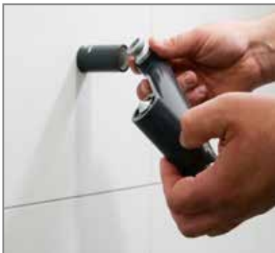
Der praktische Markierer (Dorn) hilft beim Anzeichnen.
