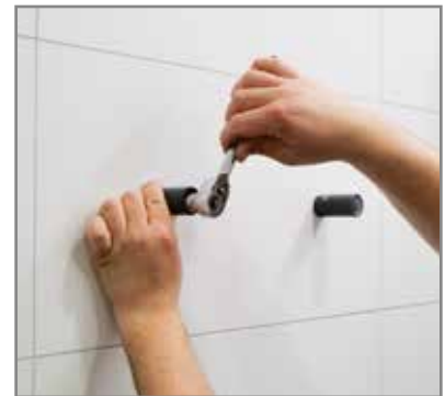
Zweites Anschlussstück montieren und ausrichten.
