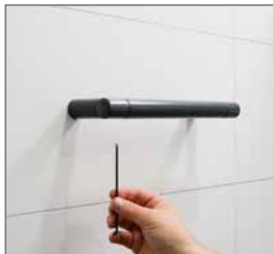
Gewindestifte eindrehen und anziehen.
