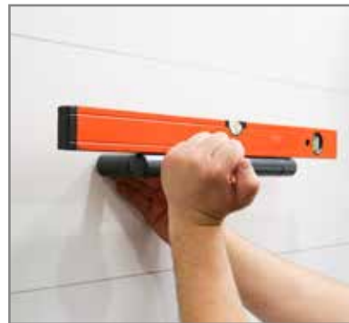
Einfaches Ausrichten des Griffes. Ein Schlag markiert den zweiten Bohrpunkt.
